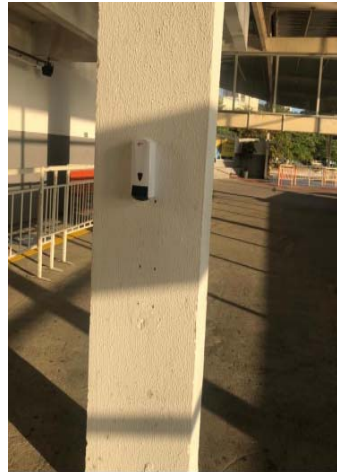
Figura 2.6 – Estação Araribóia/Dispenser com álcool em gel na área de embarque
